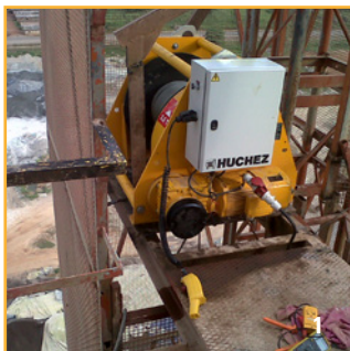
1. Levage de charges dans une cimenterie.
